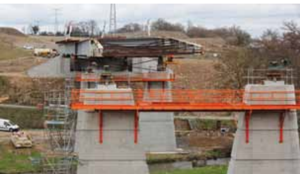
LE LANÇAGE DU VIADUC DU 18 AU 20 FÉVRIER 2014 | D1R0
